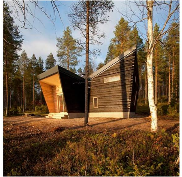
Saunapaviljonki, Lappi, Suomi. "Tilakokonaisuus lämpimien vuodenaikojen sosiaalisen elämän keskuksiksi, jossa halusin rikkoa hirsirakentamisen perinteisiä rajoja ja laajentaa puurakentamisen mahdollisuuksia", kuvailee Toni Yli-Suvanto. Valmistuu 2017, kiinteä kalustus valmistuu 2018. (KUVA: TONI YLI-SUVANTO)
